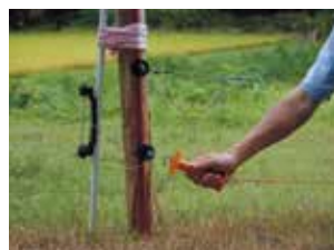
侵入防止柵の設置
