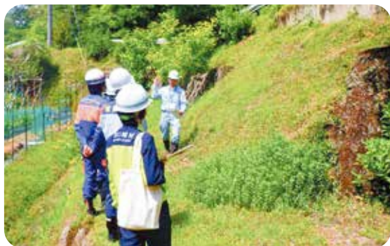
パトロールによる現場確認
