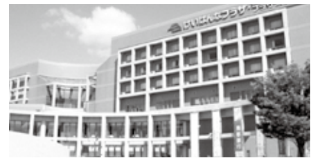
けいはんなプラザ交流棟
