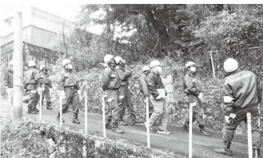
危険箇所の点検
