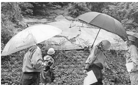
林道南大河原高尾線のがけ崩れの現状を確認
