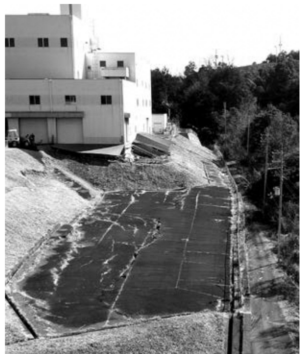
擁壁と隣接する町道の状況
