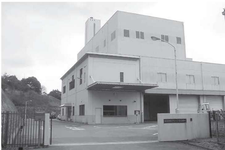
老朽化の進むクリーンセンター
