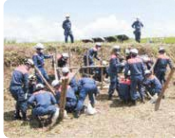
杭打ち積土のう工法
