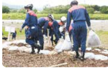
積土のう工法
